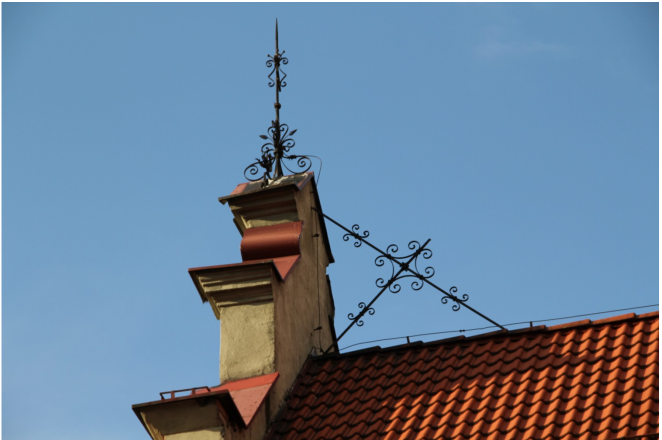
Fot. 11 – Attyka ryzalitu bocznego, stalowe wyposażenie zabezpieczające (wspornik attyki i maszt odgromowy)
