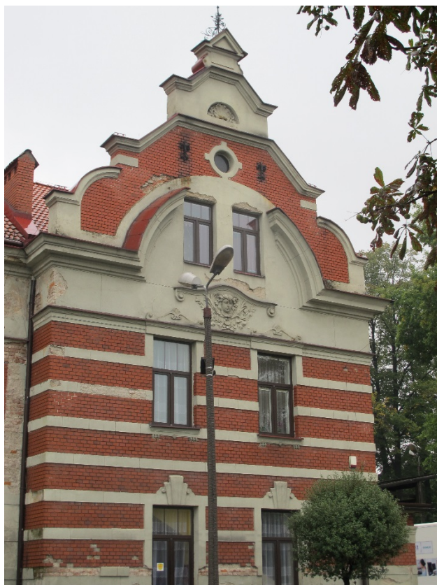
Fot.3 – Widok ryzalitu pd-zach. Widoczna deformacja elewacji poprzez wprowadzenie okien przerywających półkolisty gzyms, połączona z likwidacją rzeźby sokoła
