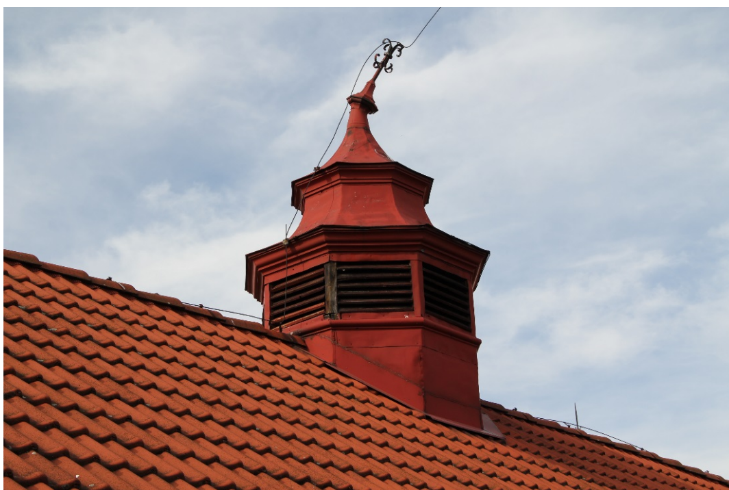
Fot. 8 – Widok na wieżyczkę wentylacyjną usytuowaną w kalenicy dachu
