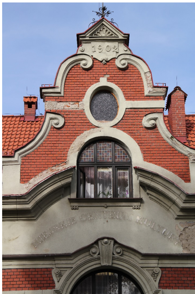
Fot. 10 – Facjata ryzalitu frontowego, widoczne wtórne przekłucie okna niekorzystnie przerywającego łukowy gzyms
