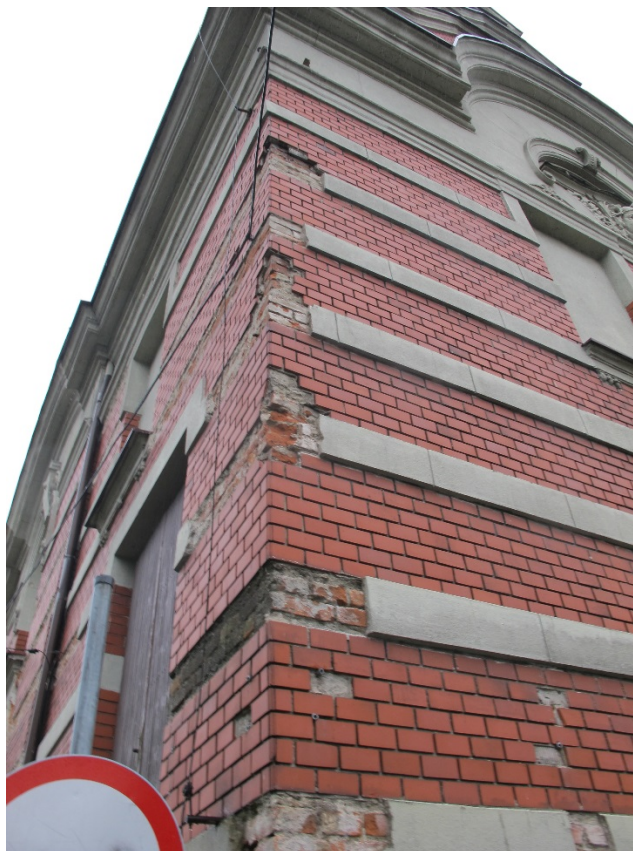
Fot. 9 – Narożnik pn-zach. Widoczne ubytki tynków i okładziny klinkierowej
