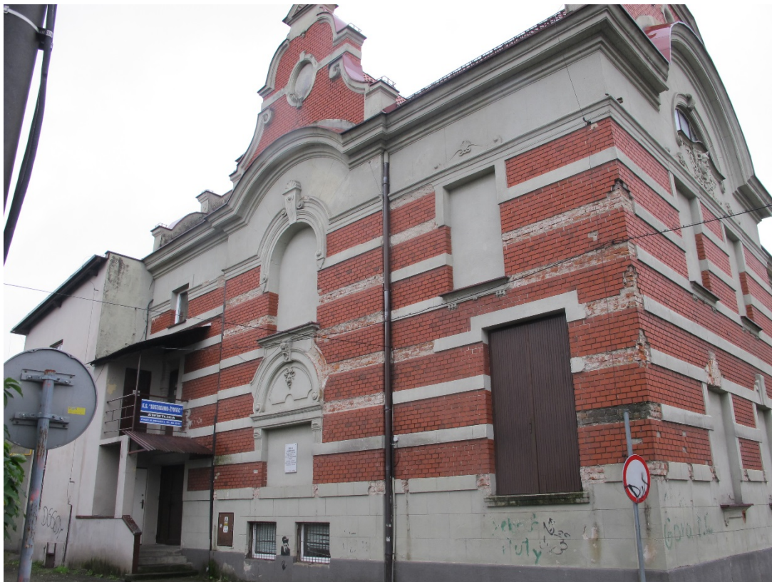
Fot. 5 – Widok elewacji pn. Widoczne liczne ubytki tynków oraz klinkierowej okładziny
