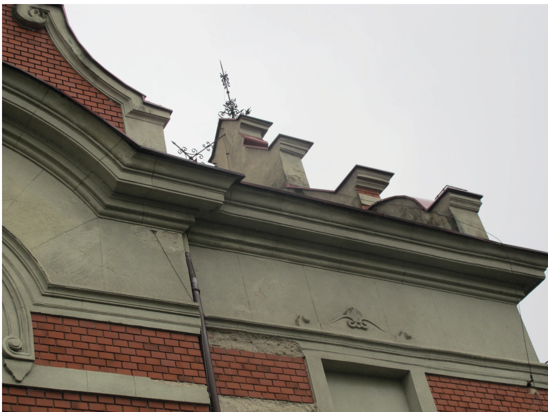
Fot. 17 – Fragment elewacji zach., widoczne ubytki tynków
