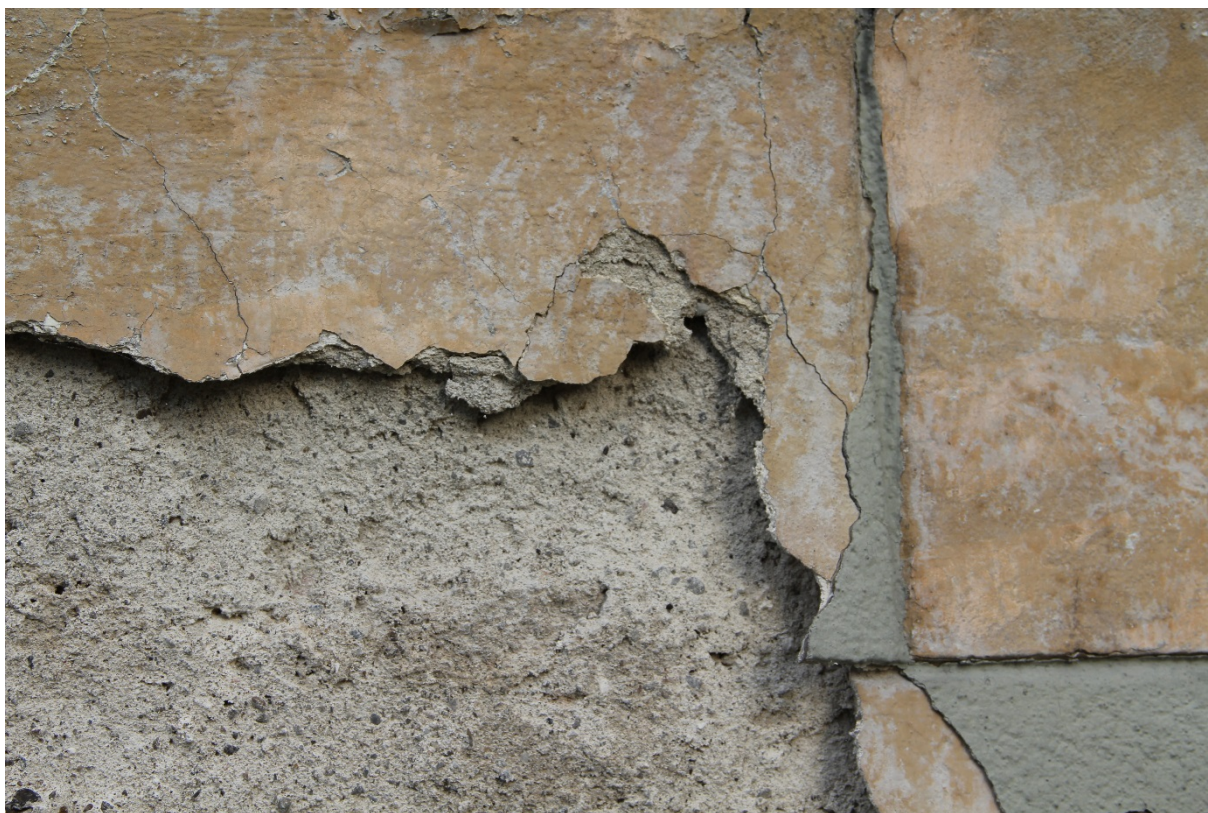
Fot. 16 – Elewacja zach. - odkrywka naturalna ilustrująca pierwotną warstwę, fakturę i kolorystykę wyprawy tynkarskiej
