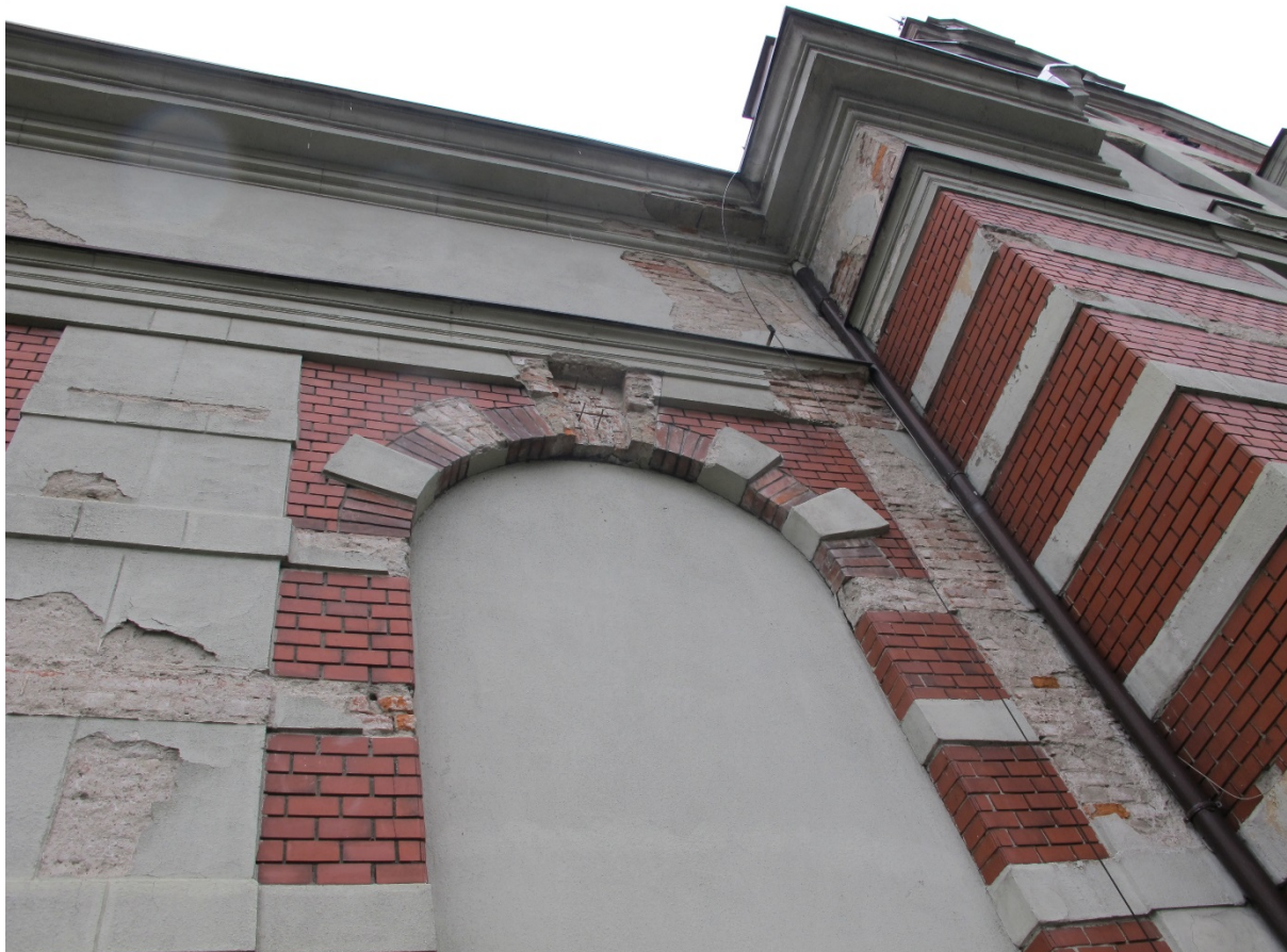
Fot. 15 – Detal elewacji zach. – widoczne liczne ubytki tynku, klinkierowej okładziny oraz elementów sztukatorskich (zwornik)
