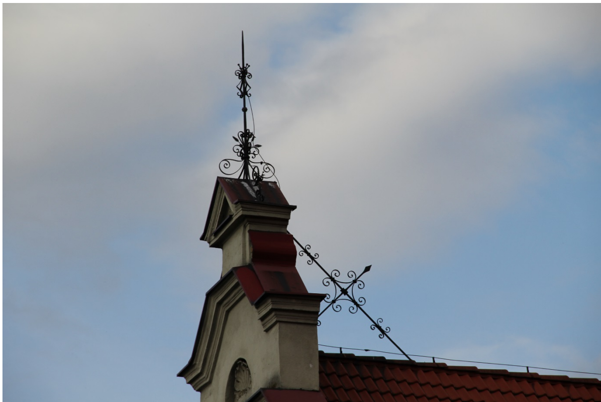
Fot. 13 – Attyka ryzalitu bocznego, stalowe wyposażenie zabezpieczające (wspornik attyki i maszt odgromowy)
