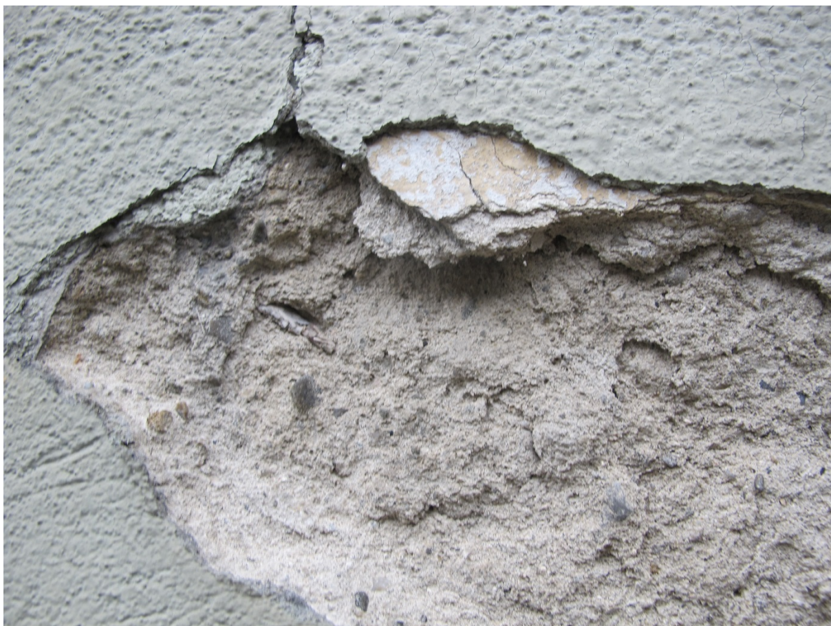
Fot. 14 – Elewacja zach. – odkrywka naturalna ilustrująca pierwotną warstwę, fakturę i kolorystykę wyprawy tynkarskiej
