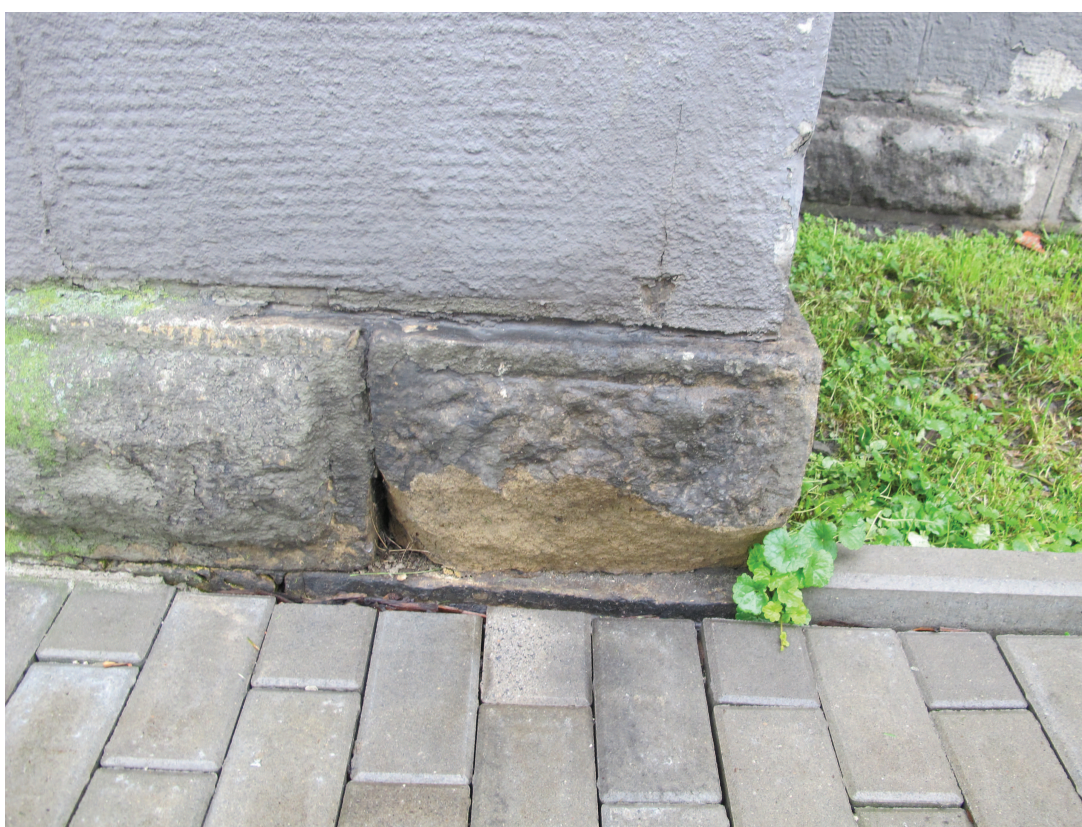
Fot. 22 – Strefa przyziemia elewacji zach. – widoczne kamienne bloki konstrukcji cokołu (piaskowiec)
