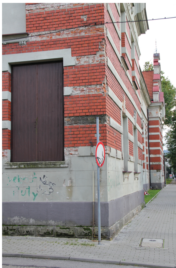
Fot. 13 elewacja zachodnia – liczne ubytki, odparzenia warstwy tynkarskiej; ubytki, uszkodzenia okładziny elewacji z płytek klinkierowych - stan techniczny bardzo zły
