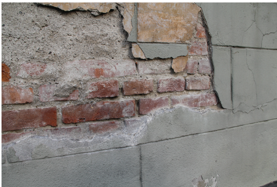
Fot. 16 ubytki warstwy tynkarskiej - stan techniczny bardzo zły
