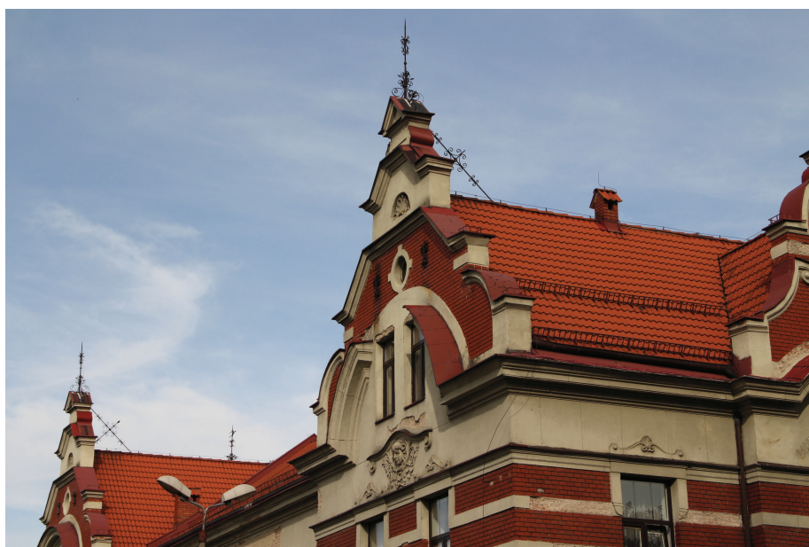
Fot. 10,11,12 elewacja zachodnia – ryzalit – w polu przerwanego gzymsu wieńczącego dekoracja w postaci dziewczęcej główki ujętej ornamentem roślinnym i spływami z palmetami – stan istniejący
