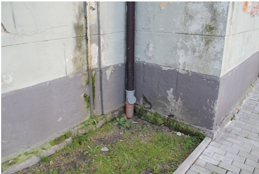
Fot. 17 destrukcja murów i powłok wykończeniowych spowodowana problemem z wilgocą gruntową – stan bardzo zły
