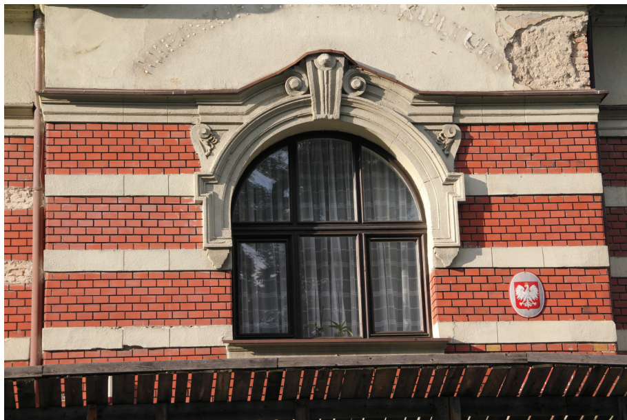
Fot. 14 elewacja północna – ubytki warstwy tynkarskiej; ubytki, uszkodzenia okładziny elewacji z płytek klinkierowych - stan techniczny bardzo zły
