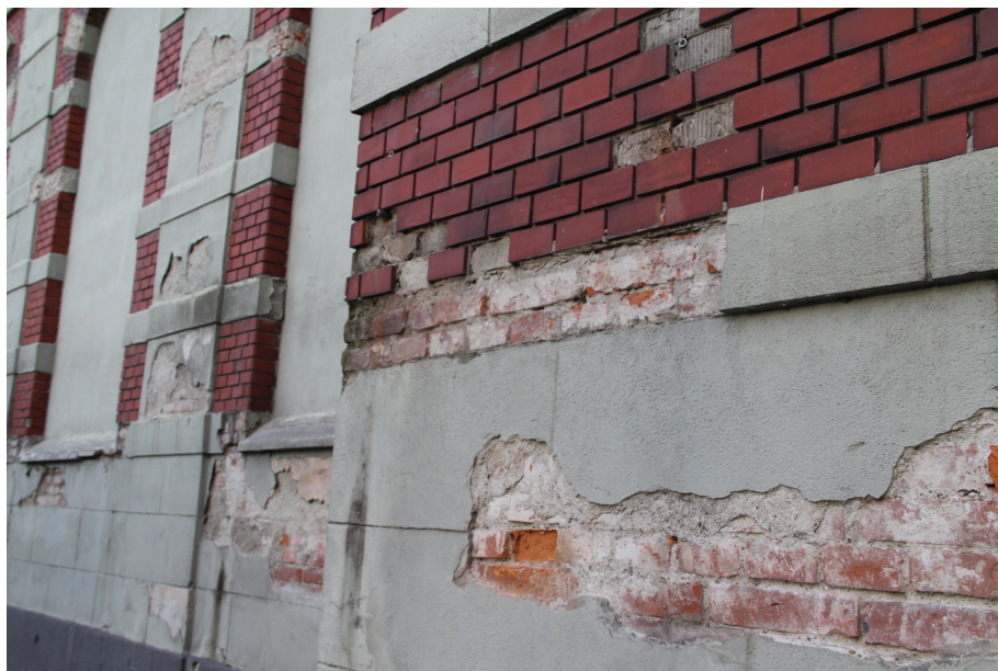
Fot. 13 elewacja zachodnia – liczne ubytki, odparzenia warstwy tynkarskiej; ubytki, uszkodzenia okładziny elewacji z płytek klinkierowych - stan techniczny bardzo zły
