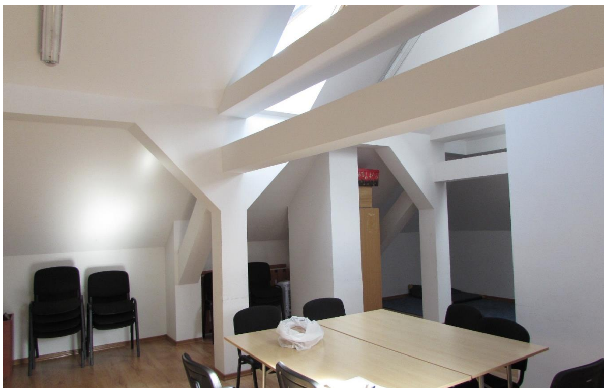
Zdj. 10. Widok konstrukcji więźby dachowej od wnętrza poddasza użytkowego. Widoczna konstrukcja obudowana płytami g-k.
