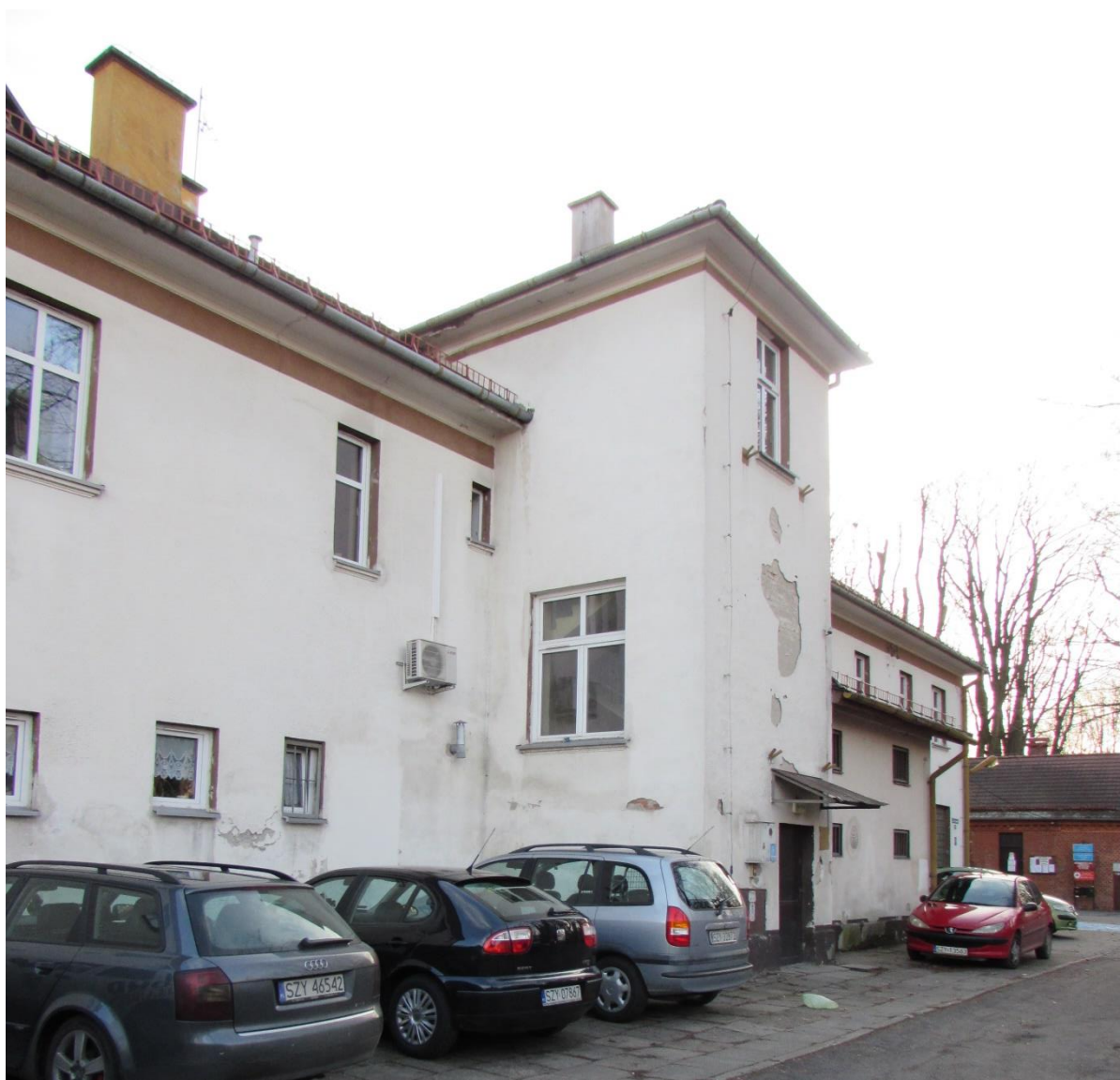
Zdj. 8. Widok elewacji południowej. Widoczne zniszczenie tynku na cokole (destrukcja biologiczna i mechaniczna). Otwory okienne o nieregularnym układzie powodują dysharmonie elewacji.
