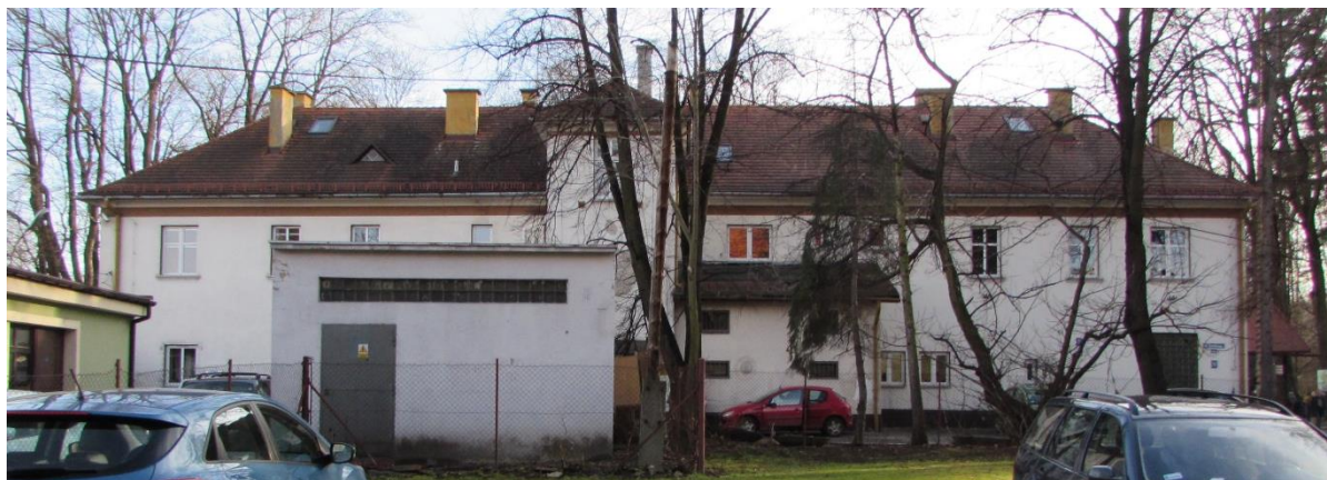
Zdj. 7. Widok części elewacji północnej. Widoczne zadaszenie wejścia do budynku. Widoczne wyraźne odspojenie tynku na elewacji. Widoczne zniszczenie tynku na cokole (destrukcja biologiczna i mechaniczna). Otwory okienne o nieregularnym układzie powodują dysharmonie elewacji. Widoczne urządzenia i instalacje na elewacji.
