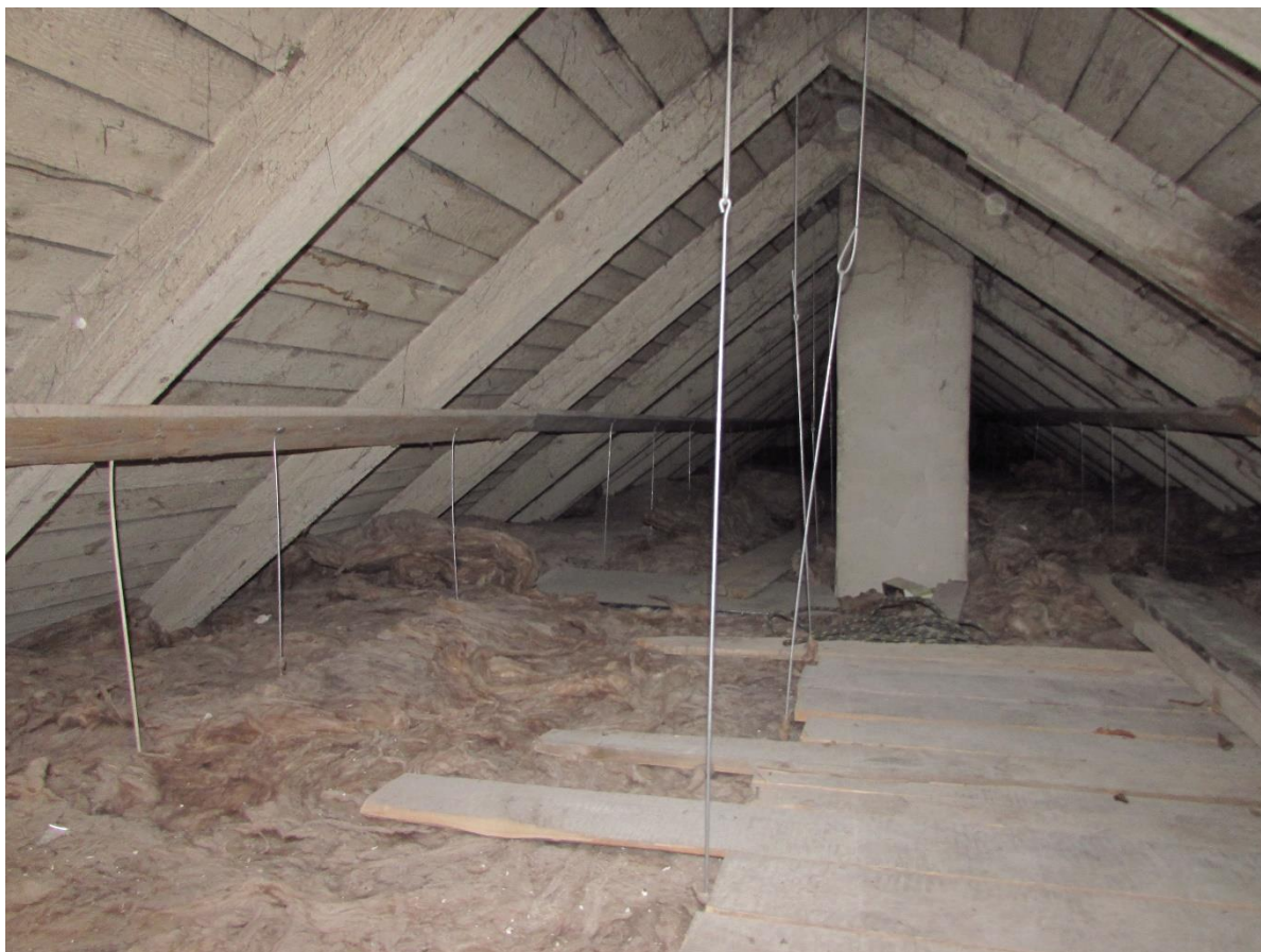
Zdj. 9. Widok konstrukcji więźby dachowej. Elementy konstrukcyjne w dobrym stanie technicznym. Widoczna termoizolacja stropu nad poddaszem użytkowym. Widoczne wieszaki podtrzymujące konstrukcję okładziny g-k. Więźba dachowa w konstrukcji wieszarowej. Krokwie przekazują obciążenia np. na płatwie, a te zaś - na wieszaki.
