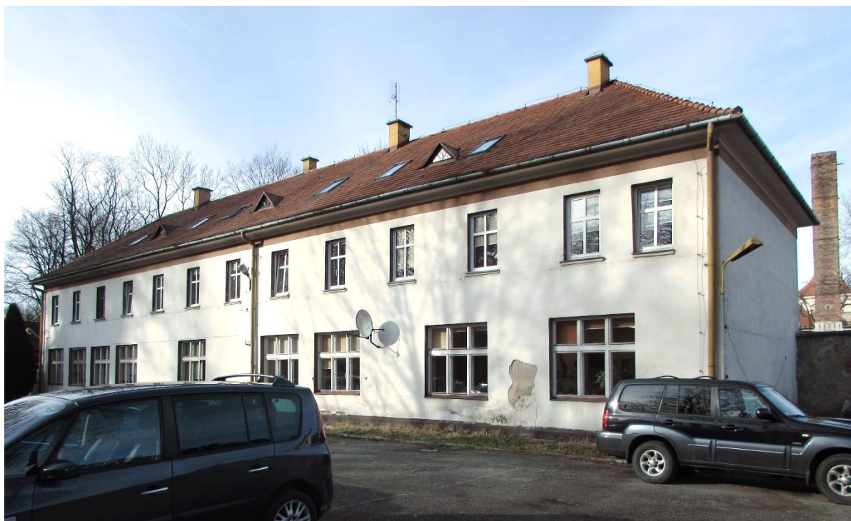
Zdj. 3. Widok budynku od strony południowo-wschodniej. Widoczne wyraźne odspojenie tynku na elewacji południowej. Widoczne zniszczenie tynku na cokole (destrukcja biologiczna i mechaniczna). Otwory okienne o nieregularnym układzie powodują dysharmonie elewacji.
