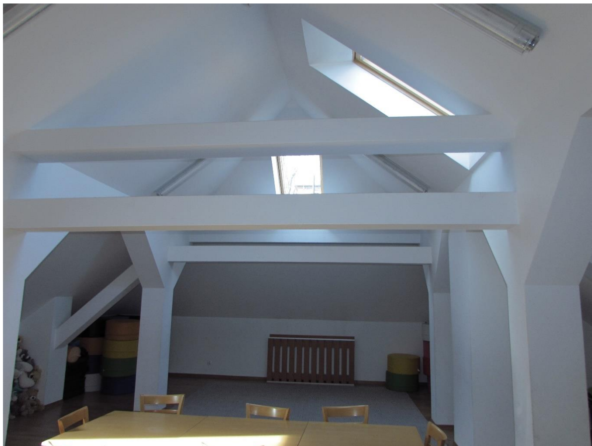
Zdj. 11. Widok konstrukcji więźby dachowej od wnętrza poddasza użytkowego. Widoczna konstrukcja obudowana płytami g-k.
