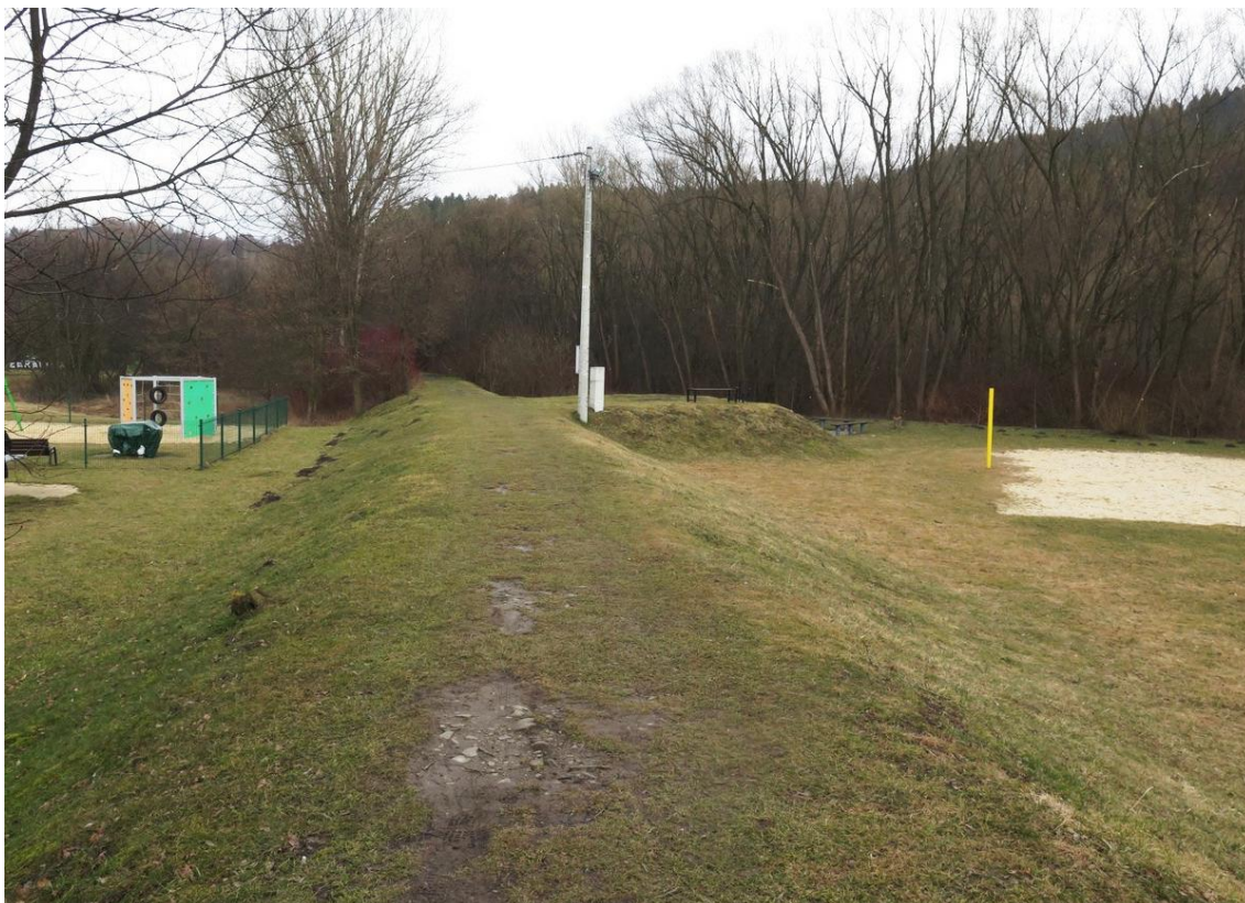
Fot. 4 Istniejący wał ziemny na odcinku 5-6 wg schematu na fot. 0. Widoczne poszerzenie wału na odcinku 6-7 wg schematu oraz lampa i skrzynka energetyczna przy poszerzeniu. Na terenie zalewowym istnieje boisko piaskowe do siatkówki, a po stronie odpowietrznej wału siłownia zewnętrzna plenerowa oraz plac zabaw.
