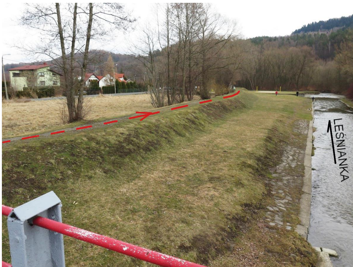
Fot. 1 Widok wału ziemnego wzdłuż lewego brzegu potoku Leśnianka z istniejącej kładki dla pieszych. Widoczny fragment wału to odcinek 1-5 wg schematu na fot. 0.
