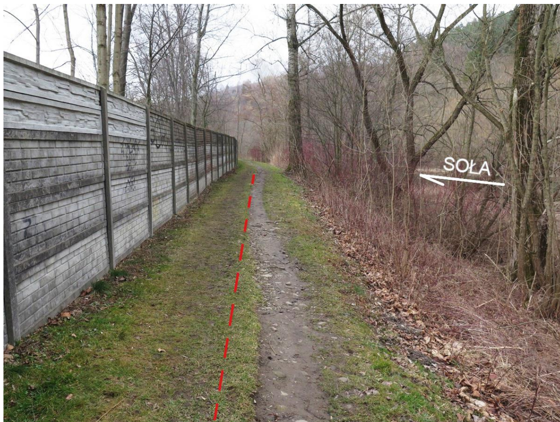
Fot. 9 Istniejący wał ziemny na odcinku 9-10 wg schematu na fot. 0. Na całej długości boiska istnieje ogrodzenie z elementów betonowych. Skarpę odwodną porastają drzewa.
