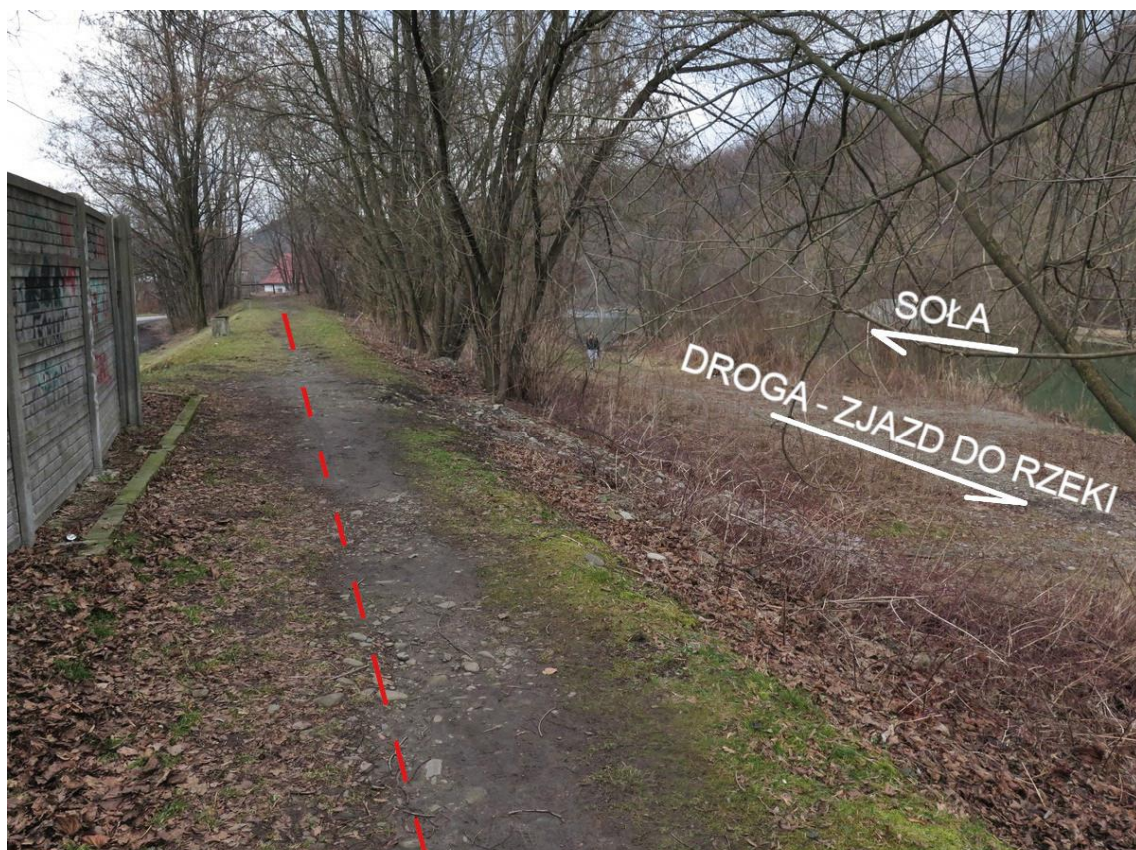
Fot. 10 Istniejący wał ziemny na odcinku 10-11-12 wg schematu na fot. 0. Wzdłuż wału od strony odwodnej istnieje droga – zjazd do rzeki. Na odcinku 11-12 skarpę odwodną porastają drzewa,
