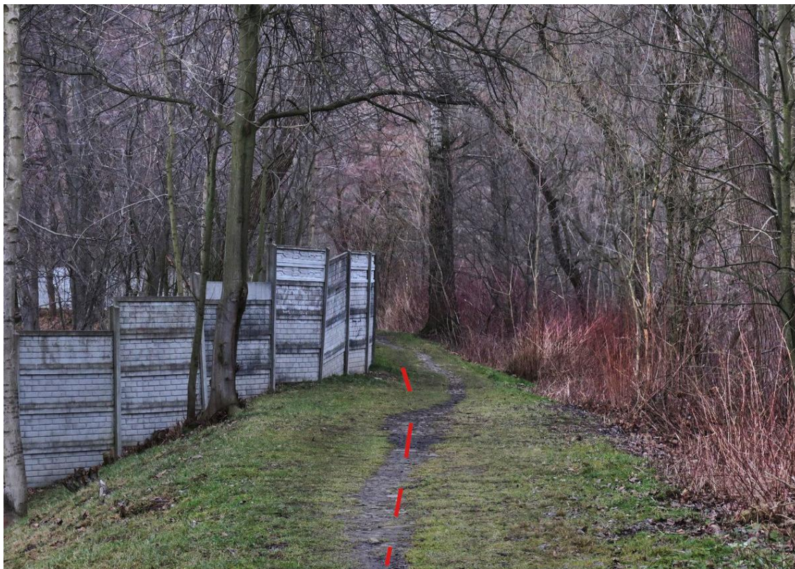
Fot. 7 Istniejący wał ziemny w rejonie p. 9 wg schematu na fot. 0. Widoczne ogrodzenie boiska TS Czarni Góral Żywiec z elementów betonowych. Ogrodzenie wykonano na koronie wału, co powoduje jej zawężanie.
