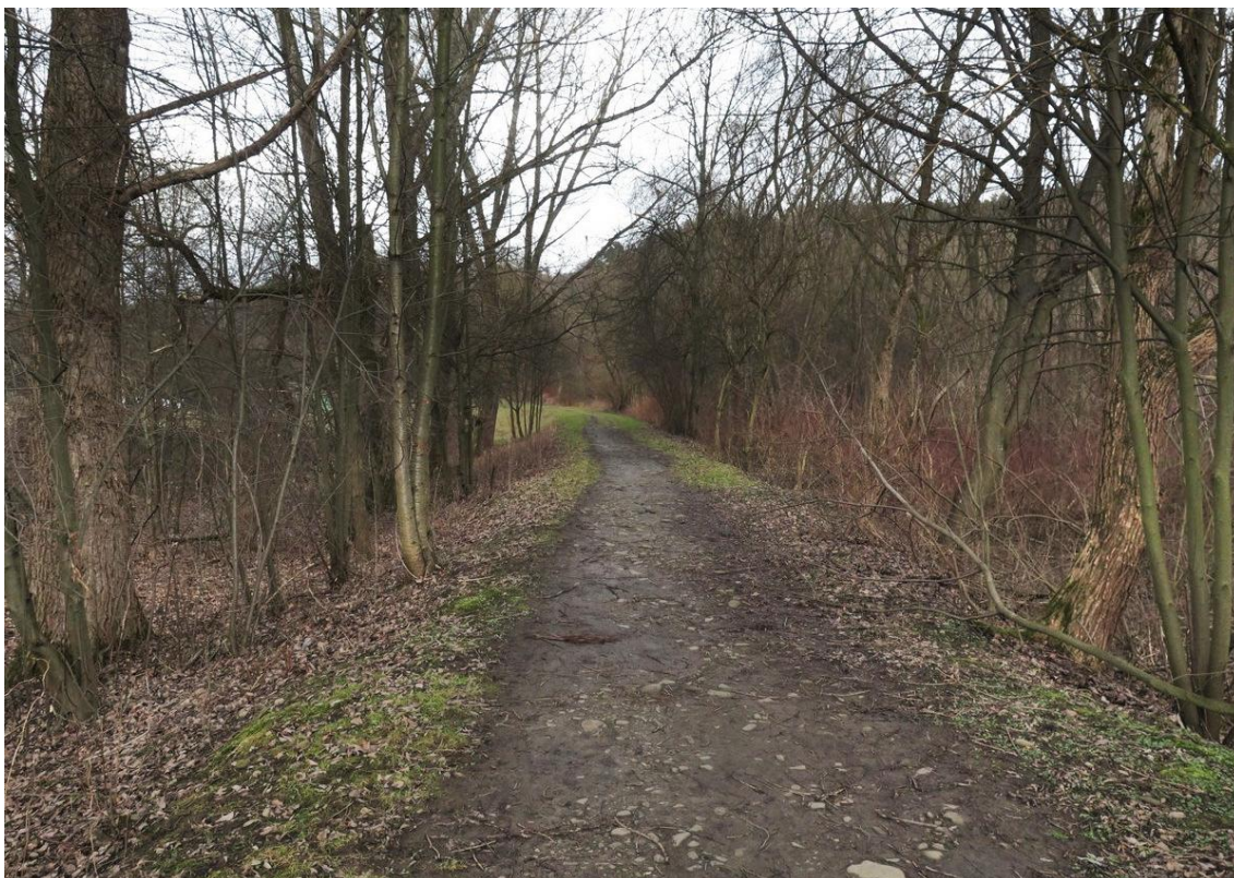
Fot. 5 Istniejący wał ziemny na odcinku 7-8 wg schematu na fot. 0. Obie skarpy wału porastają drzewa i krzaki.
