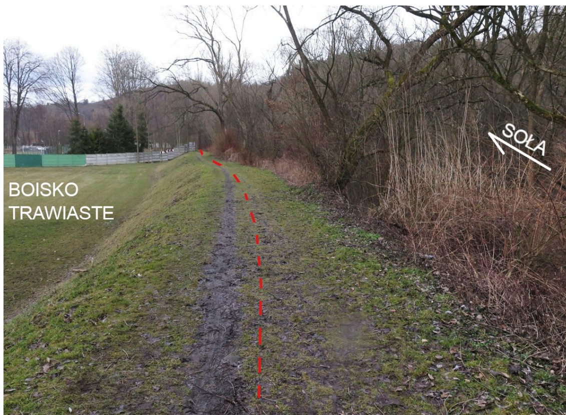
Fot. 6 Istniejący wał ziemny na odcinku 8-9 wg schematu na fot. 0. Skarpa od strony odwodnej porośnięta jest drzewami i gęstymi krzakami. Od strony przeciwnej wał graniczy z boiskiem trawiastym, skarpę porastają trawy.
