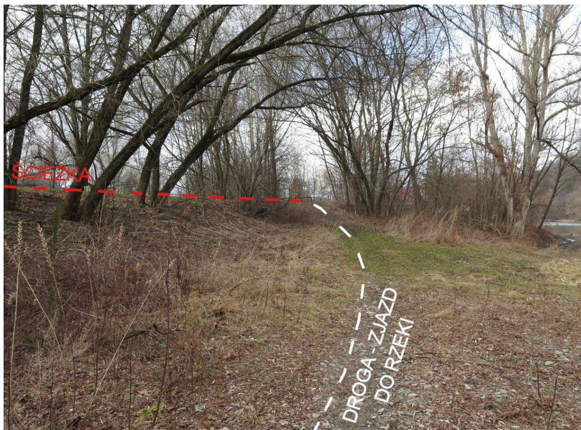
Fot. 11 Widok strony odwodnej wału na odcinku 11-12-13 wg schematu na fot. 0. Białą przerywaną linią oznaczono zjazd z korony wału na drogę do rzeki.
