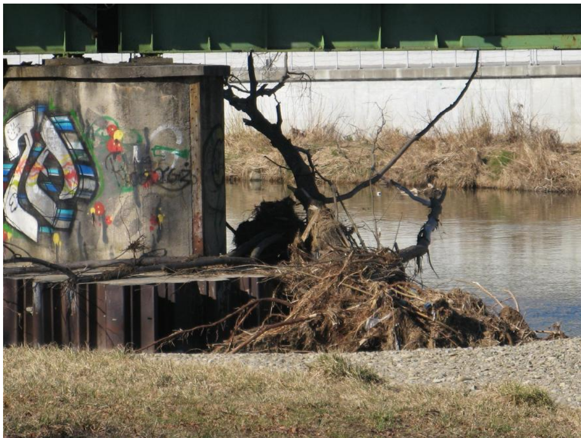
Fot. 20 Wody powodziowe rzeki Soły niosą całe drzewa. Na zdjęciu widoczne drzewo, które zatrzymało się na podporze mostu kolejowego poniżej planowanej kładki.
