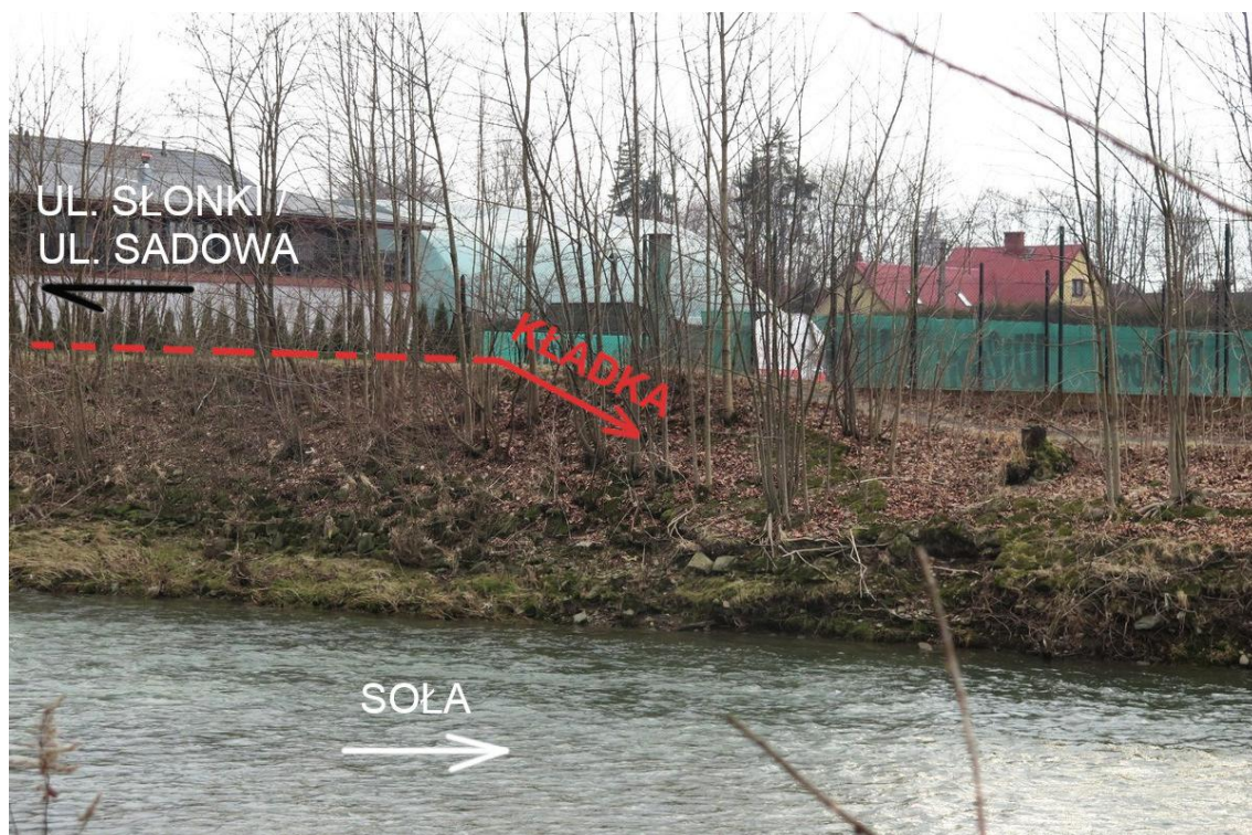
Fot. 13 Widok na lewy brzeg Soły w rejonie usytuowania podpory projektowanej kładki pieszo-rowerowej (p. 9 wg schematu na fot. 0). Na skarpie istnieje umocnienie kamienne w formie narzutu ostrego, miejscami w złym stanie technicznym. Od strony dolnej wody widoczne lokalne rozmycie skarpy.
